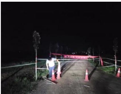
提前处理工程隐患点
