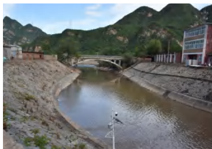
下马岭电站尾水渠完成清理
